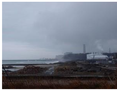
20150411 福島 48 便 (富岡町視察研修：減容施設)
