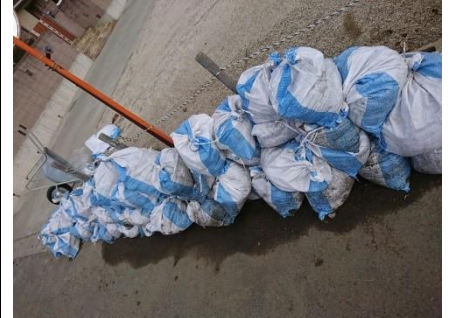
20191129 福島 117 便 (台風 19 号復旧支援 3 号) いわき市
