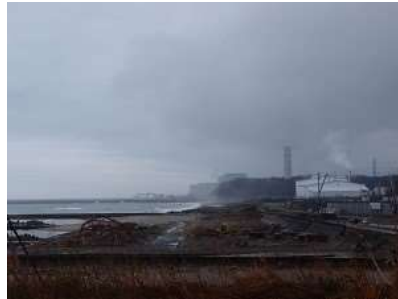
20150411 福島 48 便 (富岡町視察研修：減容施設)
