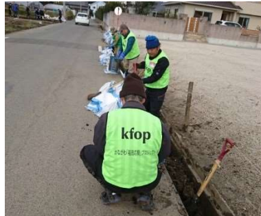
20191129 福島 117 便 (台風 19 号復旧支援 3 号) いわき市
